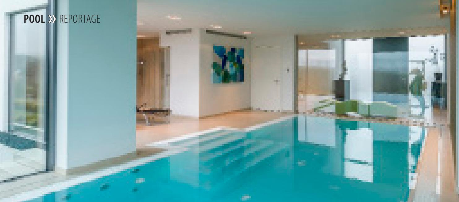
Das weiße PVC-Fertigbecken hat eine Überlaufrinne und einen seitlich angebrachten Einstieg. Auf diesem Bild sind auch die Düsen der ebenfalls seitlich angebrachten Massageanlage erkennbar. Der Pool hat keine Rollladenabdeckung – durch die Wahl der Lüftungsanlage mit mehrfacher Wärmerückgewinnung konnte darauf verzichtet werden.
