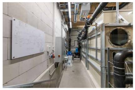
Zum Einsatz kommt Ospa-Schwimmbadtechnik für öffentliche Bäder. Die Unterdruckfiltrationsanlage wurde auf Maß in den vorhandenen Raum eingebaut. Des Weiteren gehören die Desinfektionsanlage BlueClear, Dosiertechnik für pH-Heben und -Senken, ein Schaltschrank sowie die Ospa-Steuerung BlueControl zur Ausstattung.
